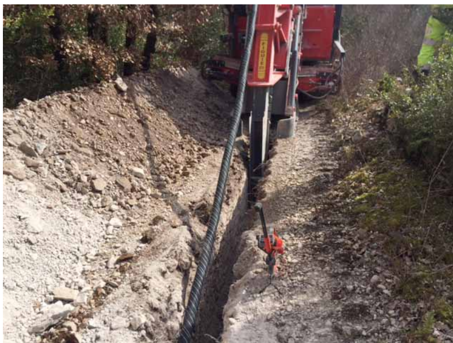
La machine qui creuse et pose le câble en même temps
